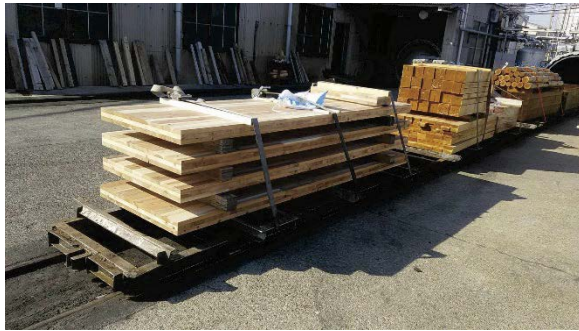
注入作業の様子
