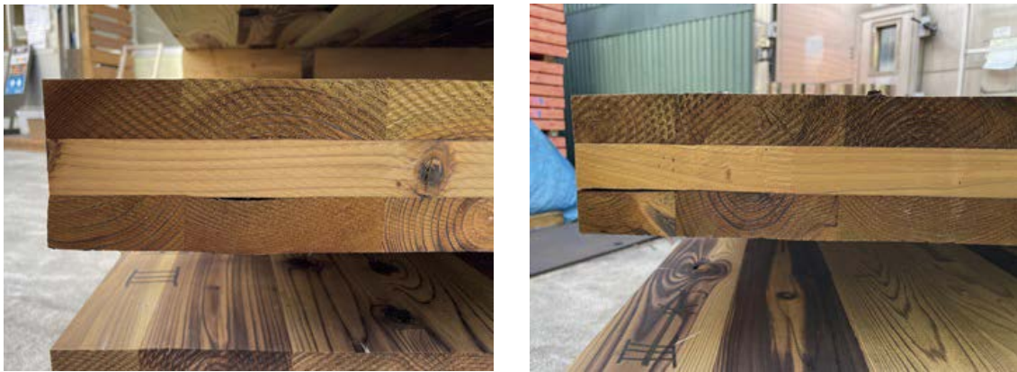
図 2. 2. 3. 3-3 積層面の剥離
