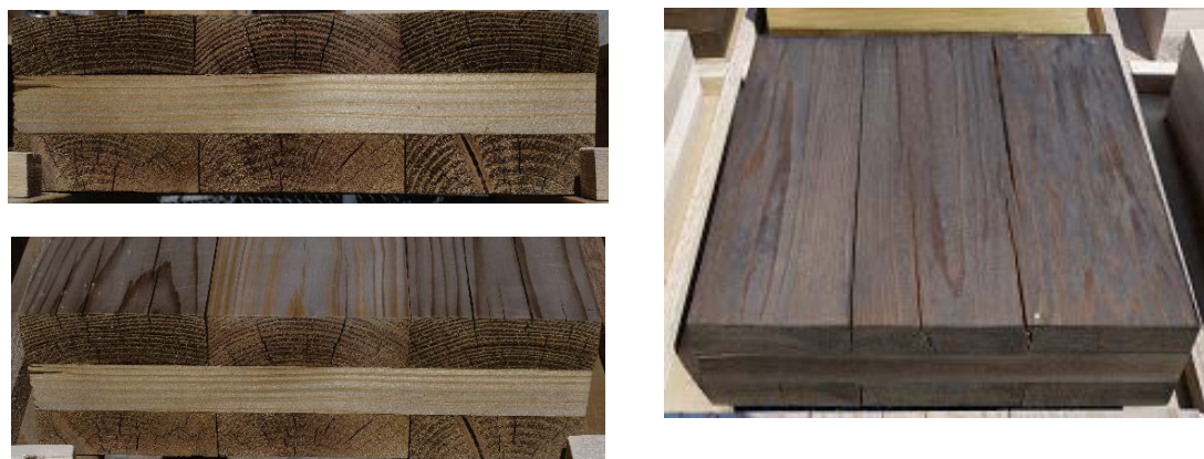
写真4.1.2-1 割れの状況（2021年4月7日：暴露開始後約6か月経過時）
