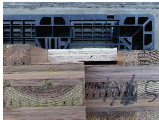
写真 2. 3. 4-9 タッピングねじの引き抜け
