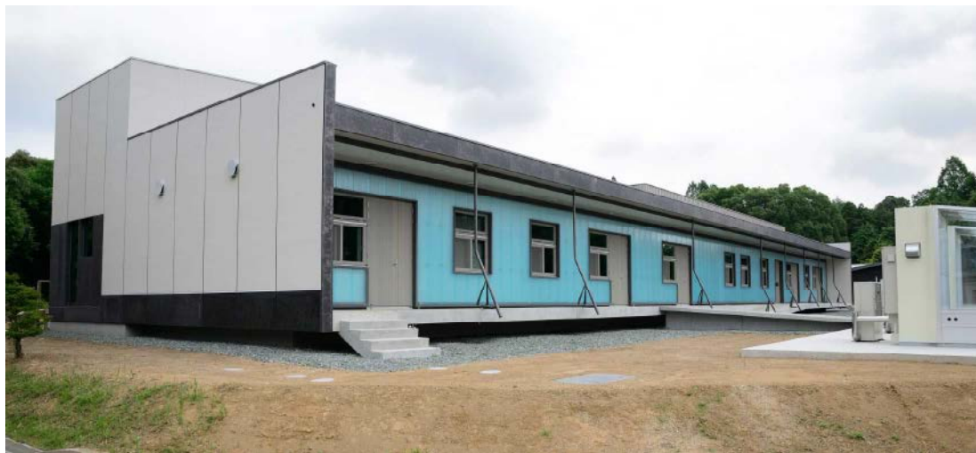
写真6-5 竣工時南面外観（2018年5月撮影）
