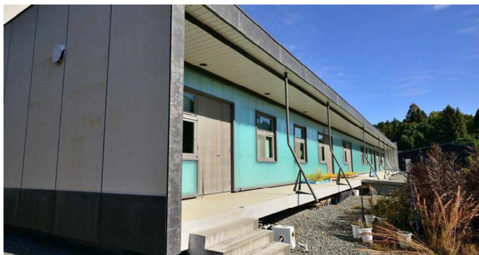
写真6-6 直近南面外観（2022年11月撮影）
