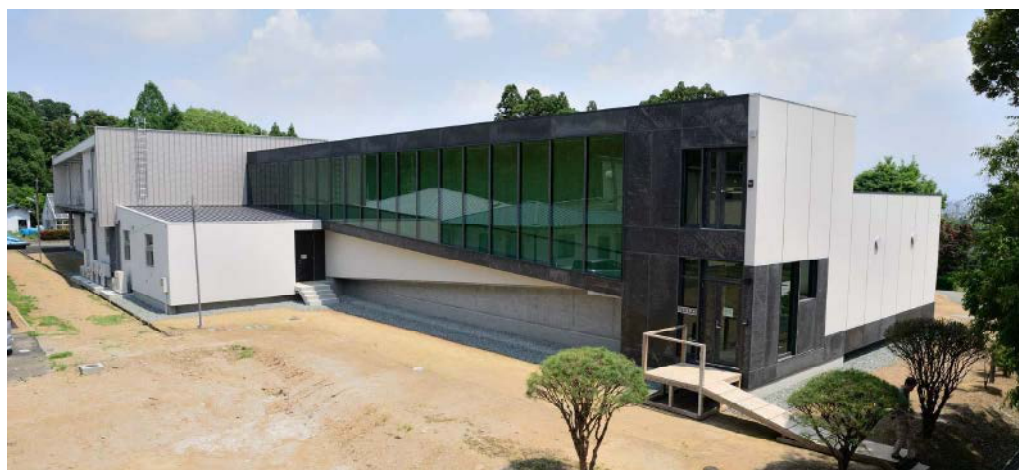
写真6-7 竣工時南面外観（2018年5月撮影）
