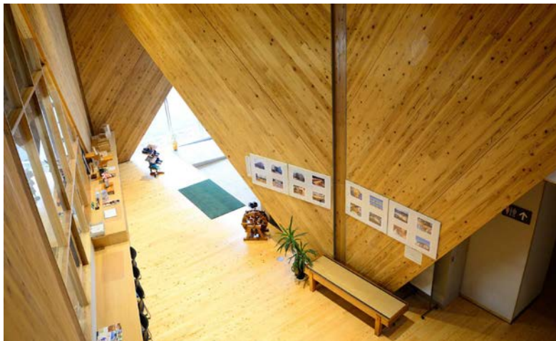
写真6-17 玄関エントランス部（通路にも壁柱が配置）（2013年12月撮影）
