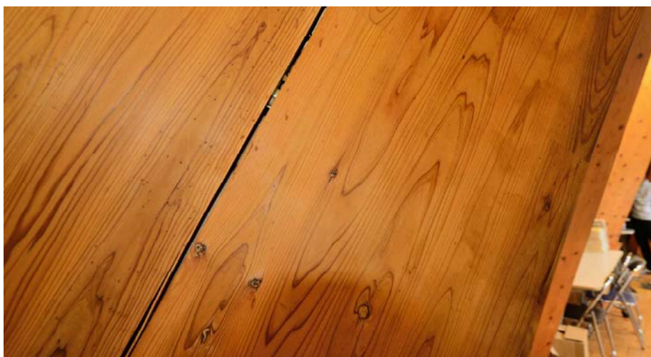
写真6-22 接着合わせ材一壁柱詳細(2022年11月撮影)
