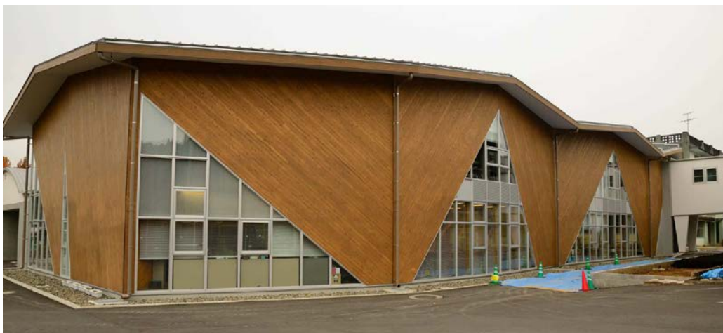
写真6-12 建物外観(2013年12月撮影)
