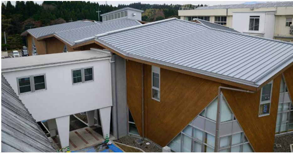
写真6-13 屋根折板（谷もある複雑な形状）（2013年12月撮影）
